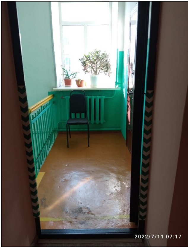
40.Площадка перед лестницей 2 этажа
