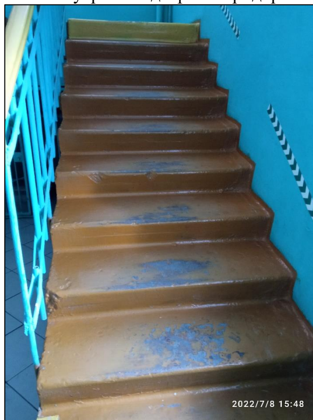
35. Лестница на 1 этаже
