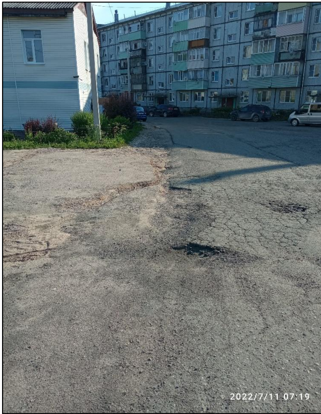
4. Неровности асфальтового покрытия
