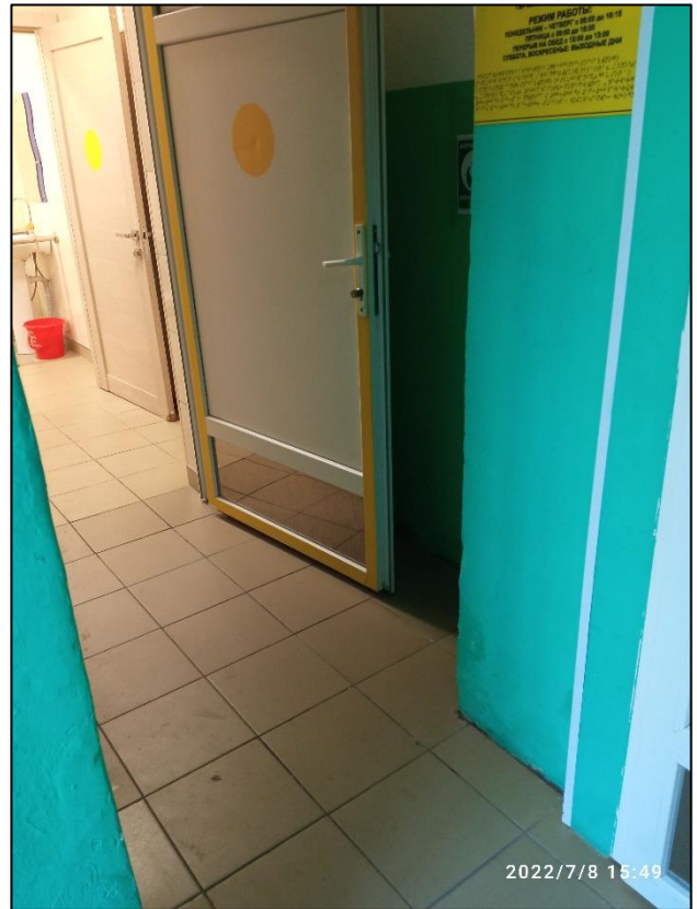
67. Вход в санузел
