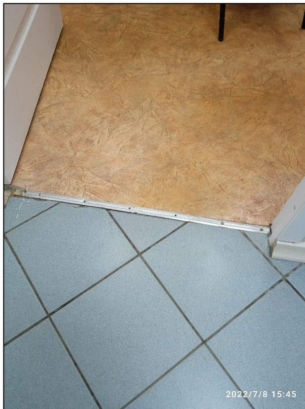
49.Проем и порог входа в кабинет 2
