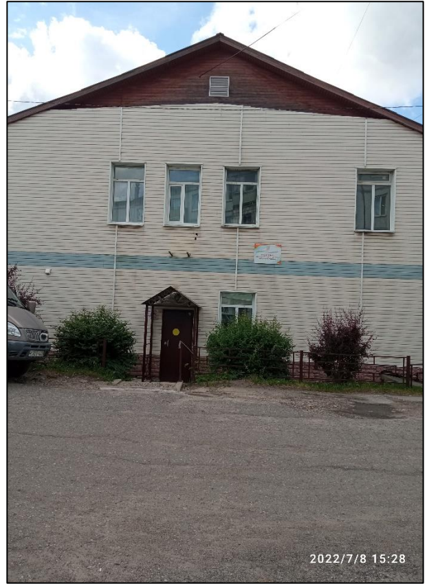
9. Территория перед торцевым входом
