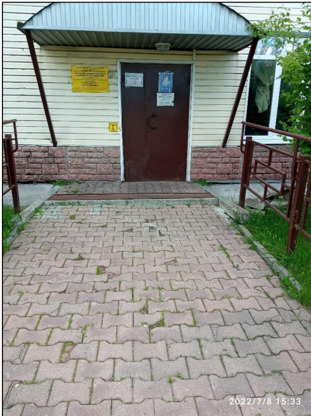
14. Подход к центральному входу
