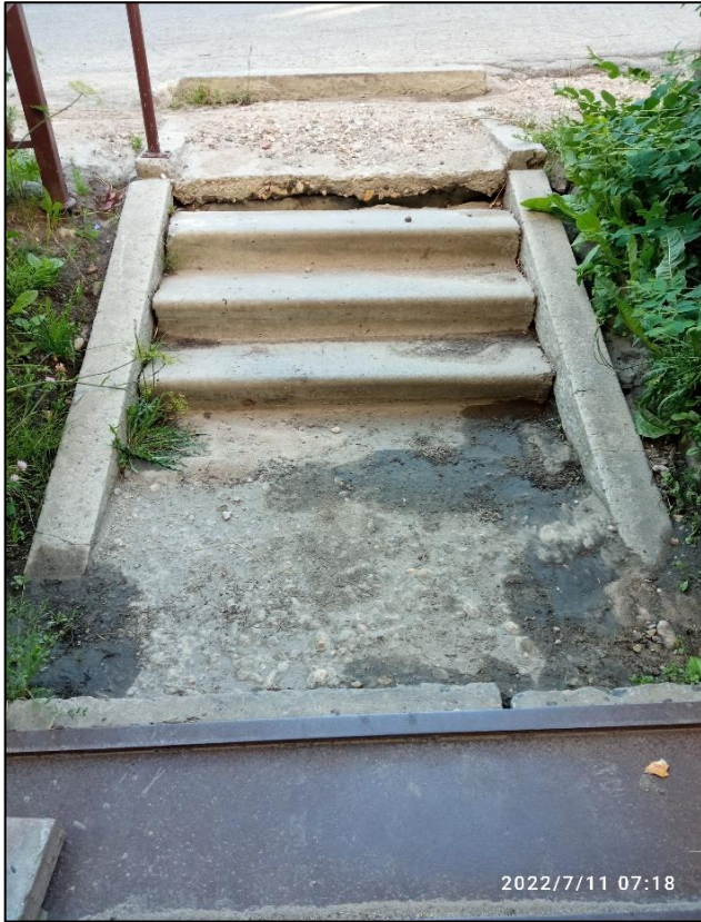
28. Лестница входа с торца
