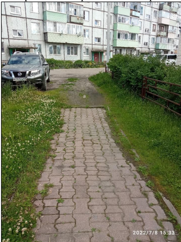
6. Дорожка к зданию
